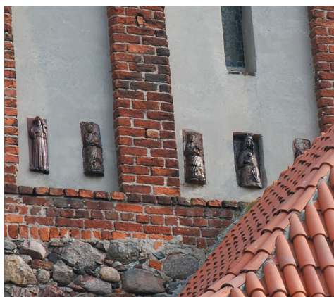
fot. 5 – rzeźby ceramiczne w elewacji zachodniej
