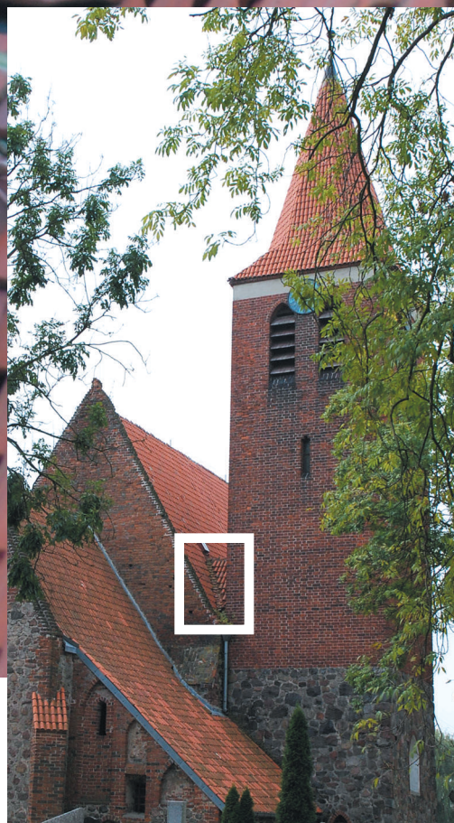
fot. 16 – wieża i fragment dachu od strony północnej
