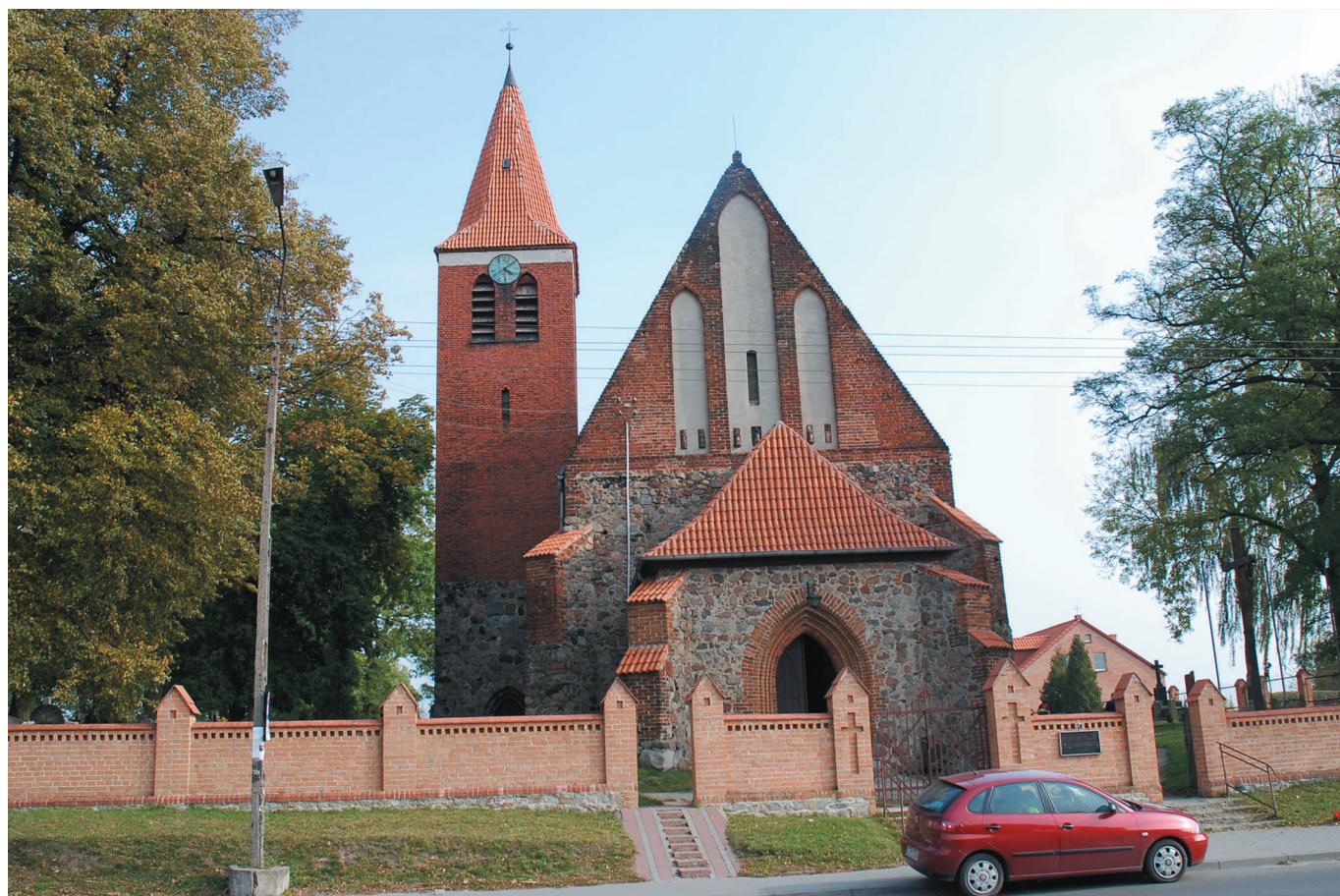
fot. 1 – widok elewacji zachodniej
