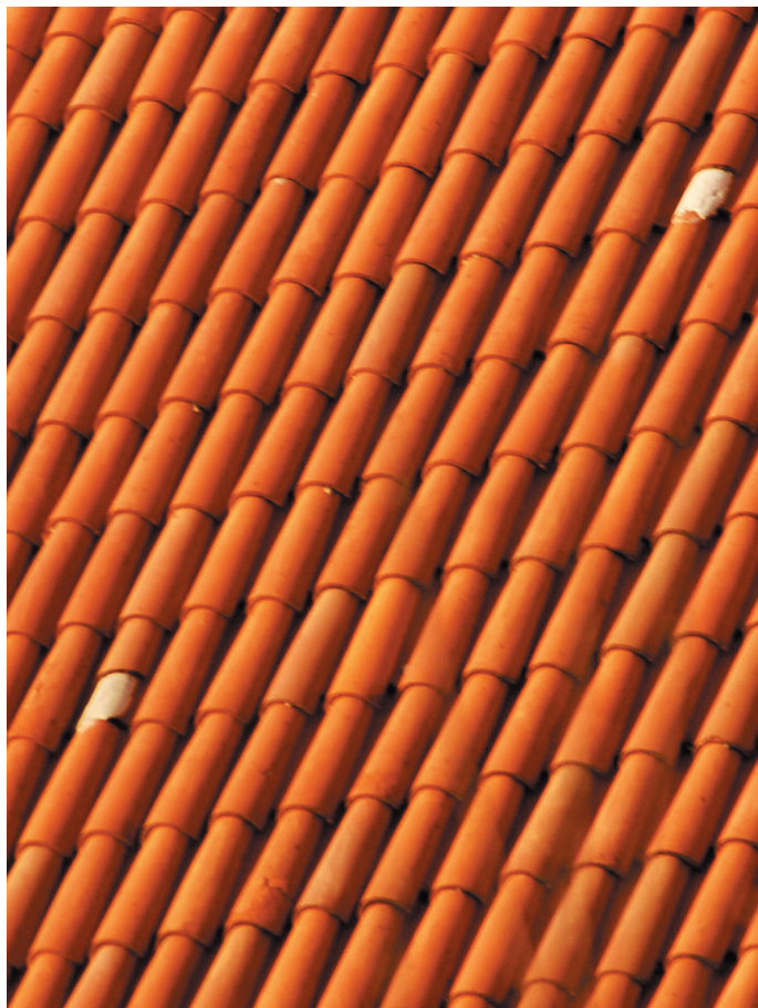
fot. 9 – dach od strony południowej – detal
