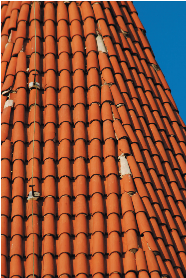
fot.11 – widok wieży od strony południowej, fragment
