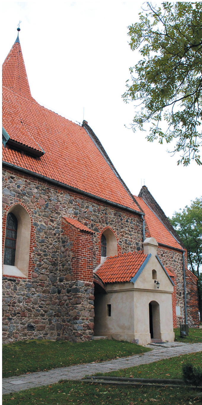
fot. 4 – elewacja południowa, fragment
