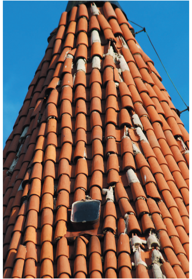
fot.12 – widok wieży od strony zachodniej, fragment
