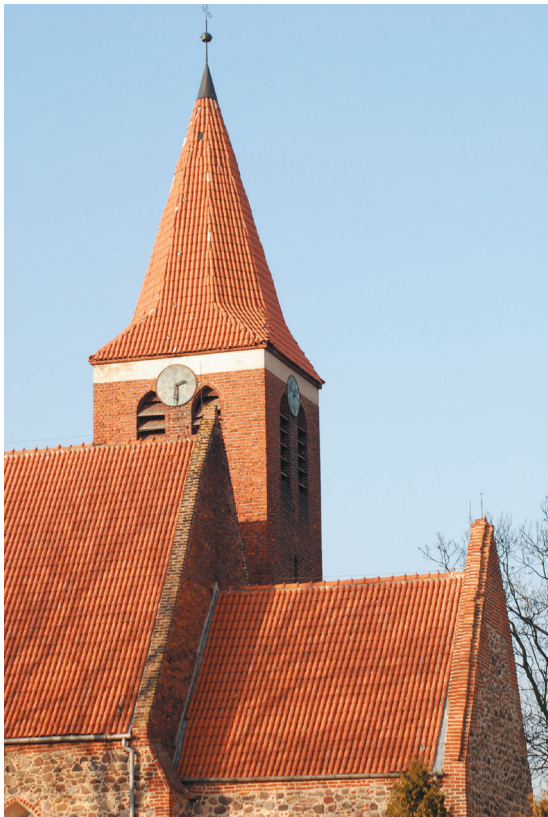
fot.13 – widok wieży od strony południowo-wschodniej
