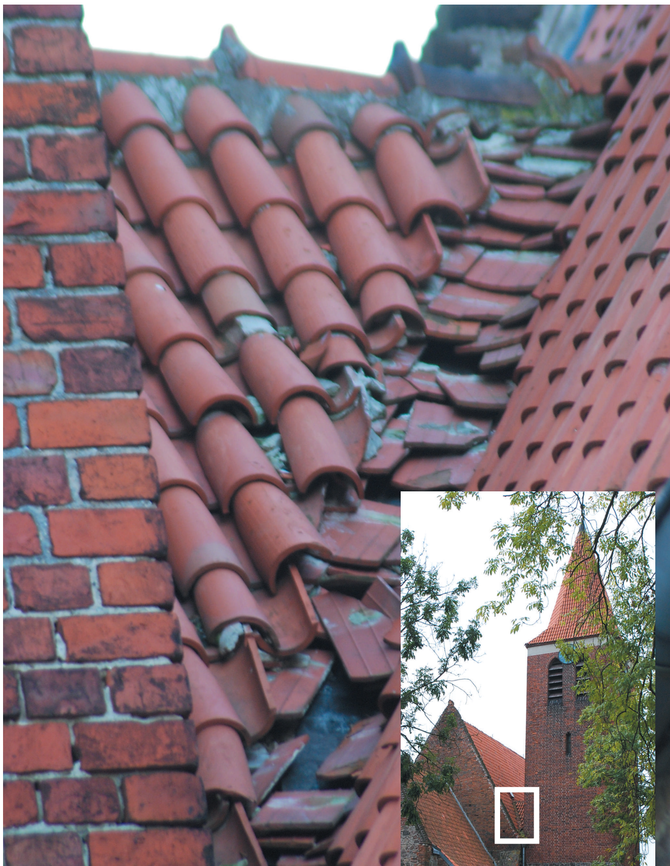
fot. 15 – kosz pomiędzy połacią dachową kościoła a ścianą wieży
