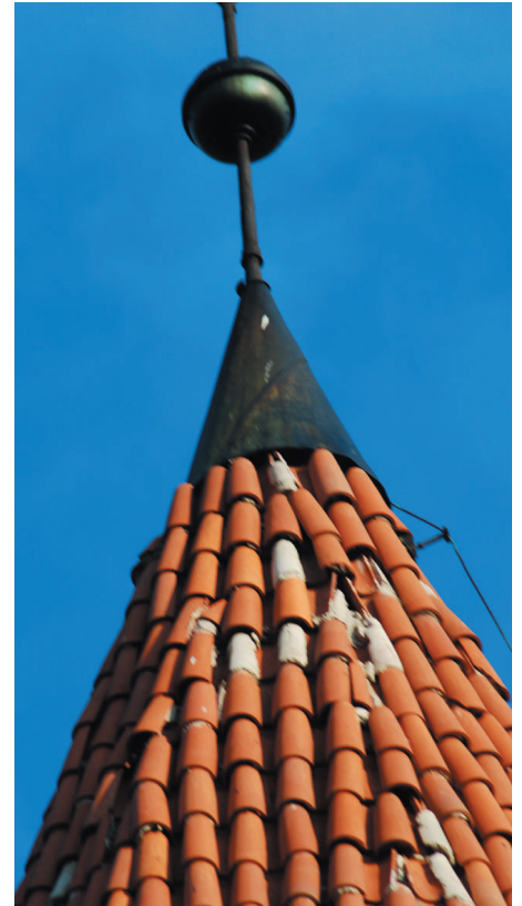
fot.14 – widok zakończenia wieży od strony zachodniej
