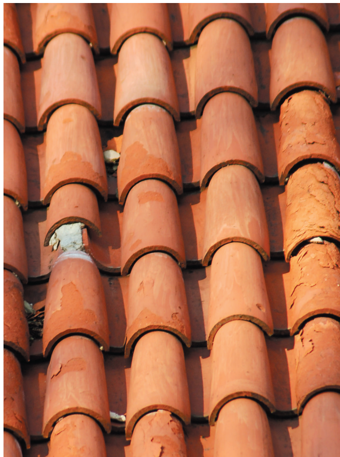
fot. 10 – dach od strony południowej – detal
