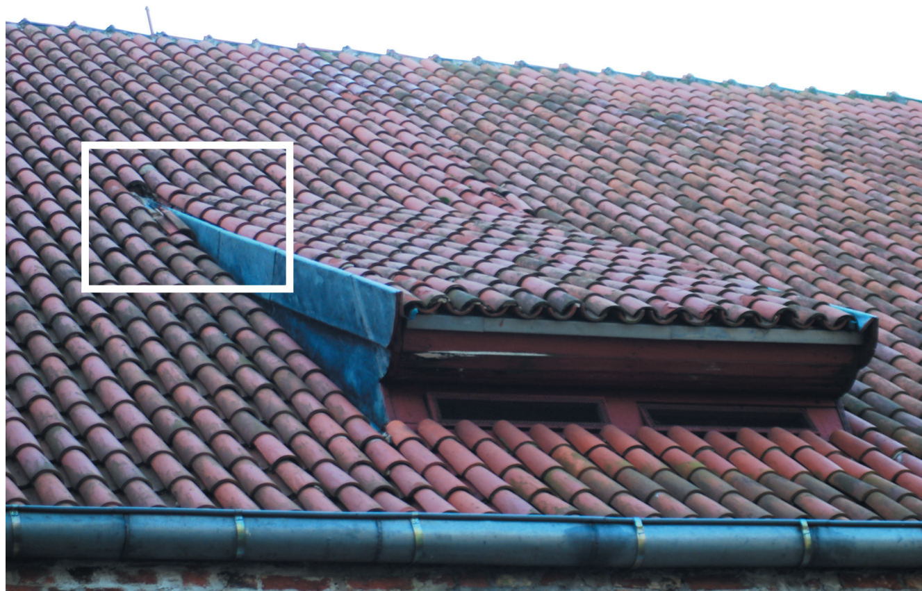
fot.17 – fragment pokrycia dachowego z lukarną od strony północnej
