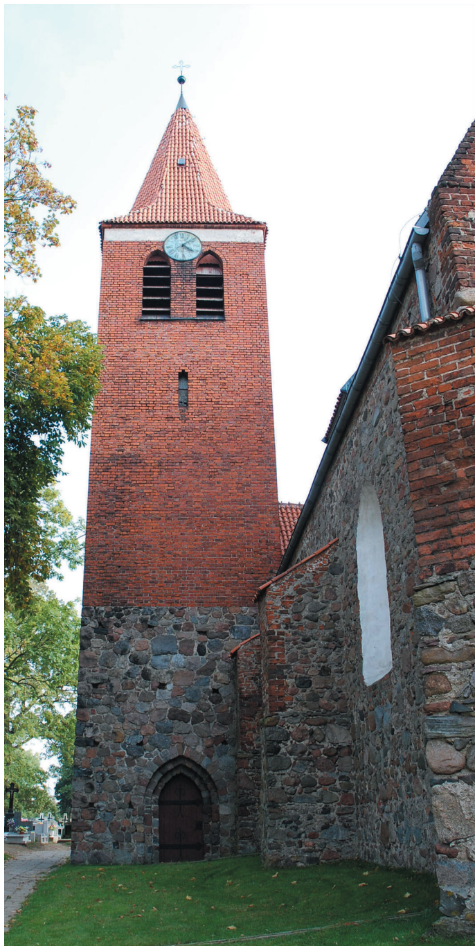
fot. 3 – elewacja północna, fragment
